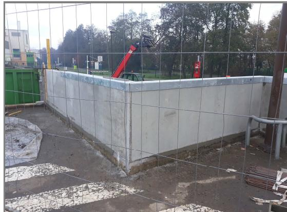
**Figure n° 7 : Rehausse des voiles, après travaux**
