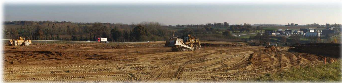
Figure 19 : Vue des terrassements dans le cadre de l'aménagement de la tranche I du Parc d'Activités de la Tourelle – Atlas des Paysages des Côtes d'Armor
