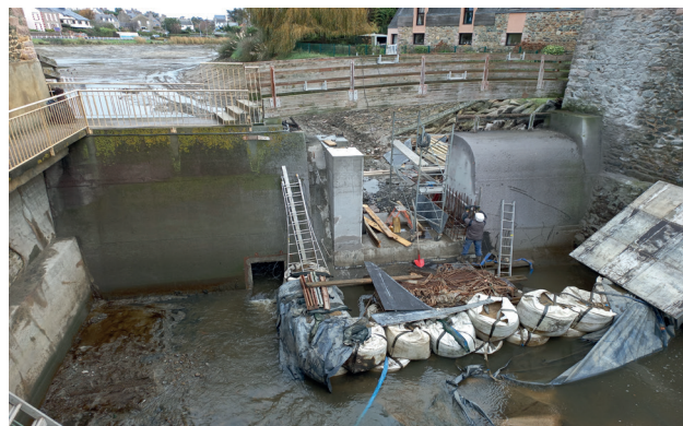
Installation d'une double vanne à l'étang de Dahouët
