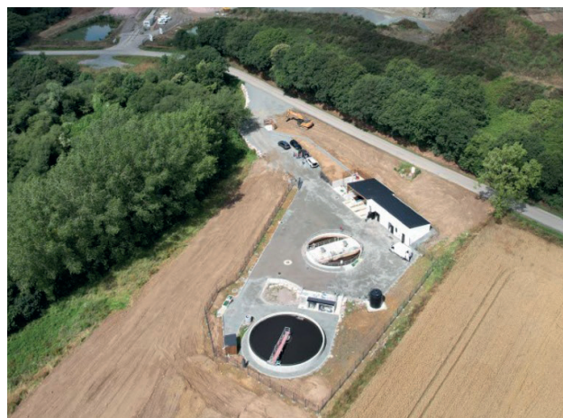
Nouvelle station d'épuration des eaux usées d'Hénansal et La Bouillie
