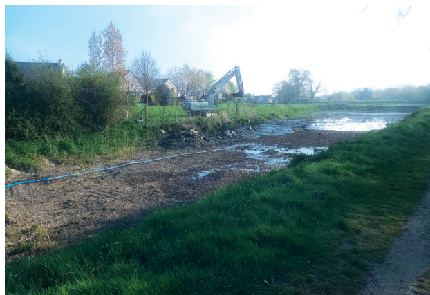
Remise à niveau des bassins du Bocage
