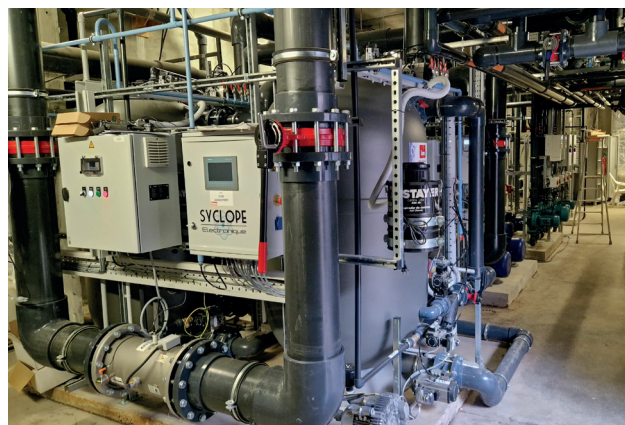
Modernisation du système de filtration de La Piscine à Lamballe-Armor
