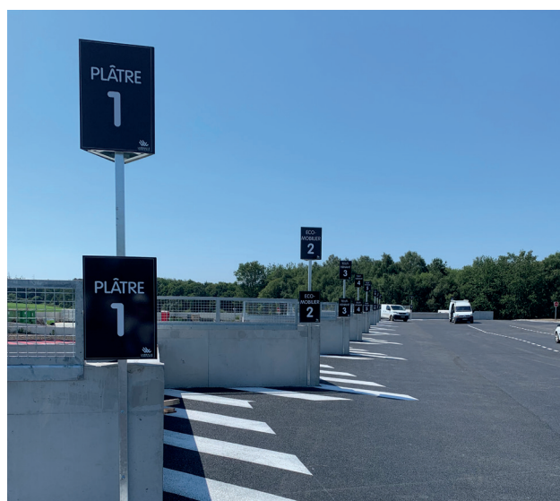
Nouvelle déchèterie de Jugon-les-Lacs
