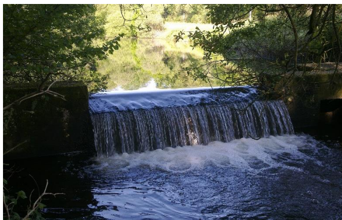
Ancien seuil de Kerbellec à Pluméliau
