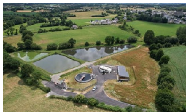
Station d'épuration de Bréhand
