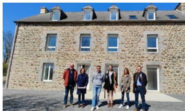
Réhabilitation de logements sur Saint-Aaron à Lamballe-Armor
