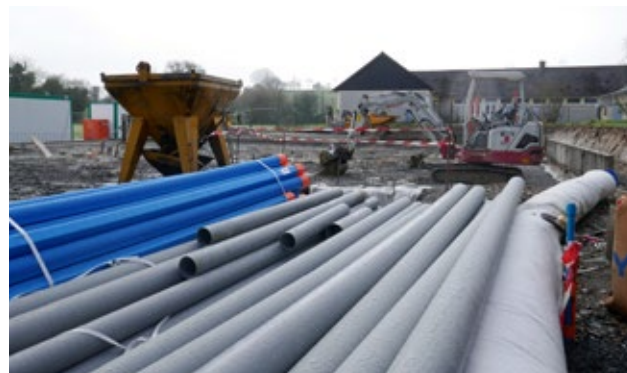
Lancement des travaux de la micro-crèche de Plémy
