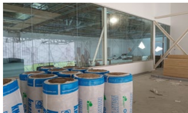
Fin des travaux de la Halle des Sports du Liffré à Lamballe-Armor
