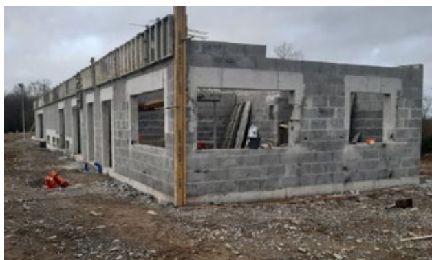
Travaux de la nouvelle déchèterie de Jugon-Les-Lacs-Commune-Nouvelle
