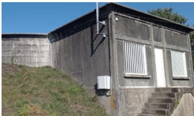
Travaux du réservoir d'eau potable de Saint-Lazare
